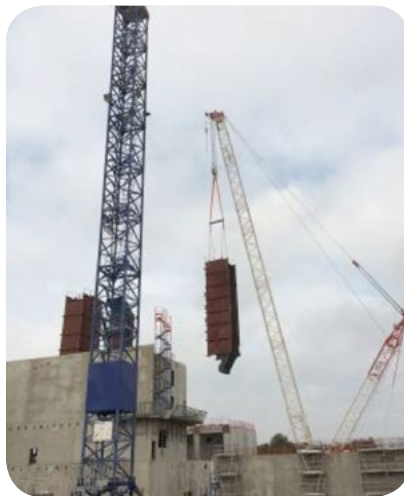
Grutage de la chaudière sur la charpente métallique.
